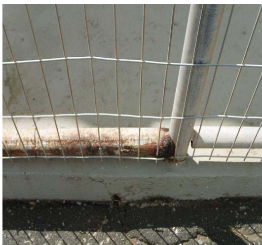
Fotos n. os 09 e 10: Estrutura metálica (alambrados ao redor do campo) com problema de oxidação e rompimentos por falta de manutenção.
