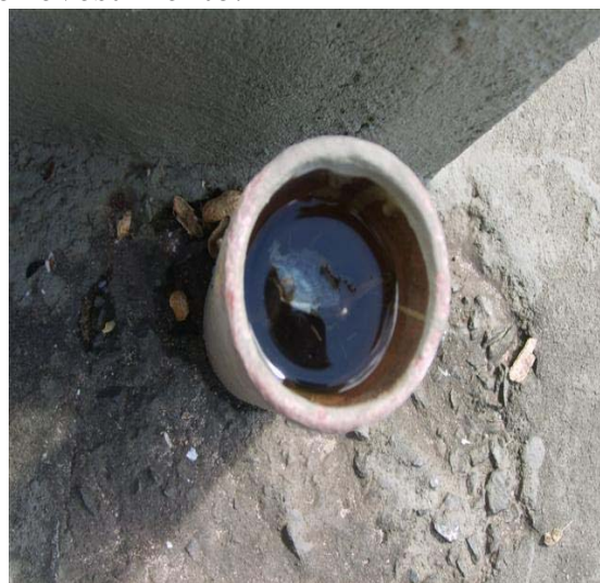
Fotos n.ºs 07 e 08: Arquibancadas com pontos de alagamentos, mostrando a deficiência da drenagem da mesma.
