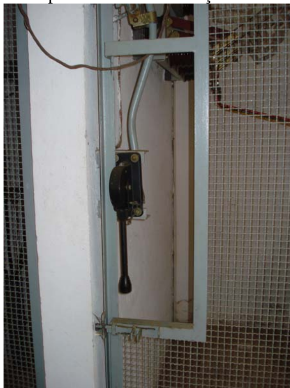
Fotos n. os 12 – Chave seccionadora
