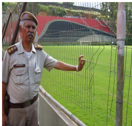
Fotos n. os 09 e 10: Estrutura metálica (alambrados ao redor do campo) com problema de oxidação e rompimentos por falta de manutenção.
