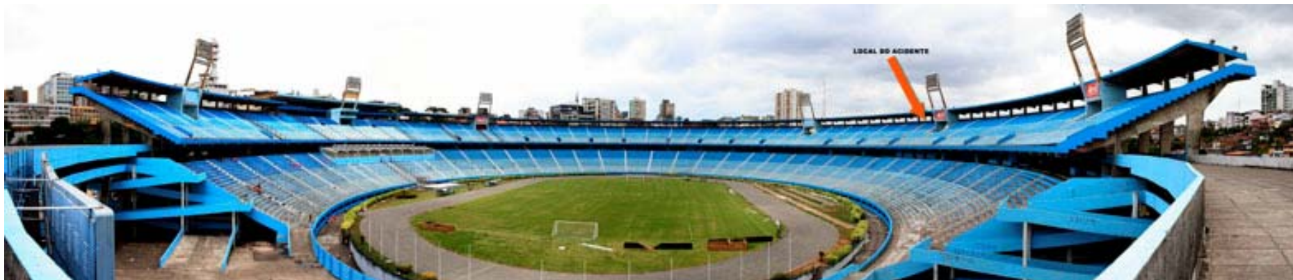
Foto 02 – Vista panorâmica do estádio Octávio Mangabeira, observando-se ao fundo o local do sinistro.
