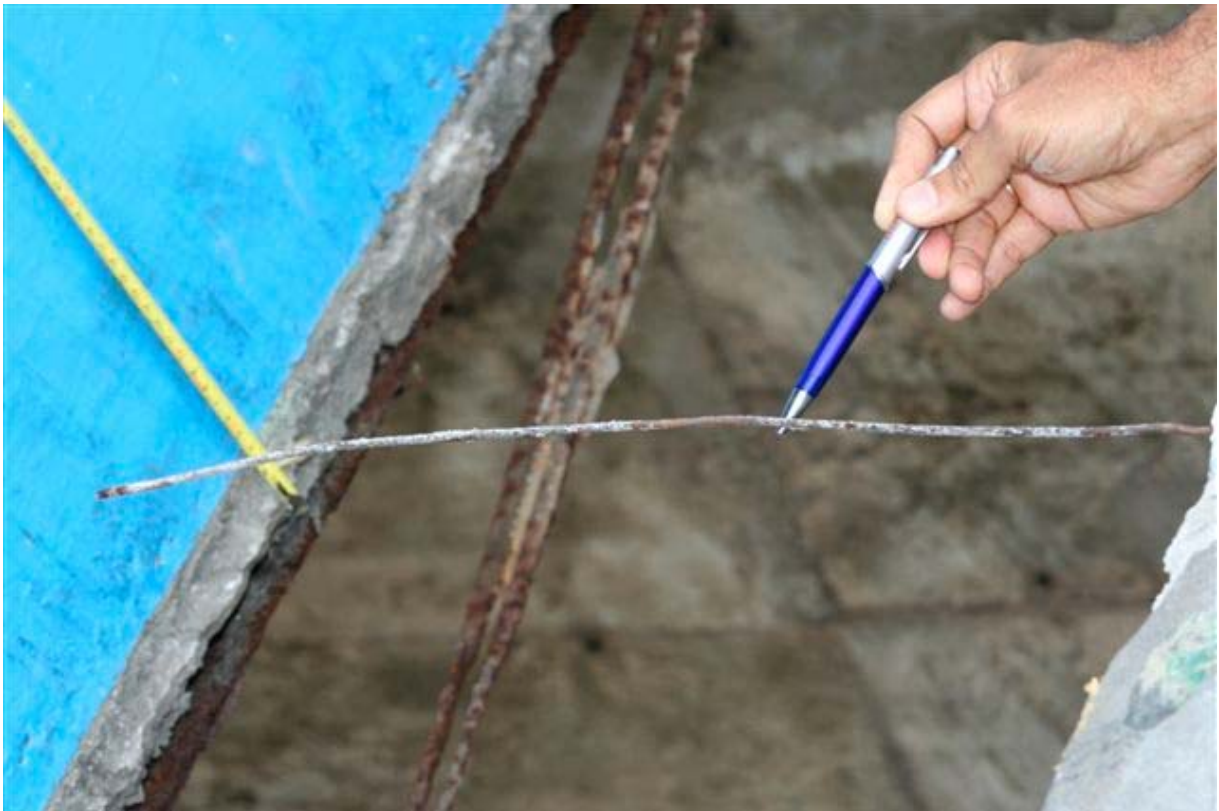
Foto 08 – Detalhe da armadura da laje.
